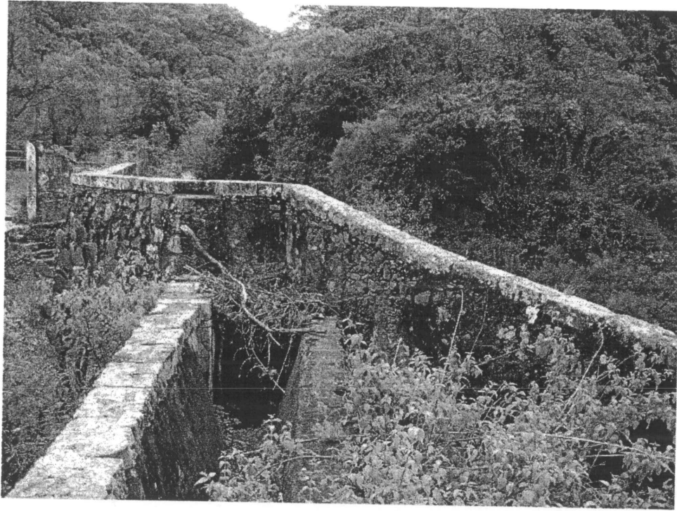
Ilustración 11: Estructuras de conducción de la planta de filtración de 1907.
