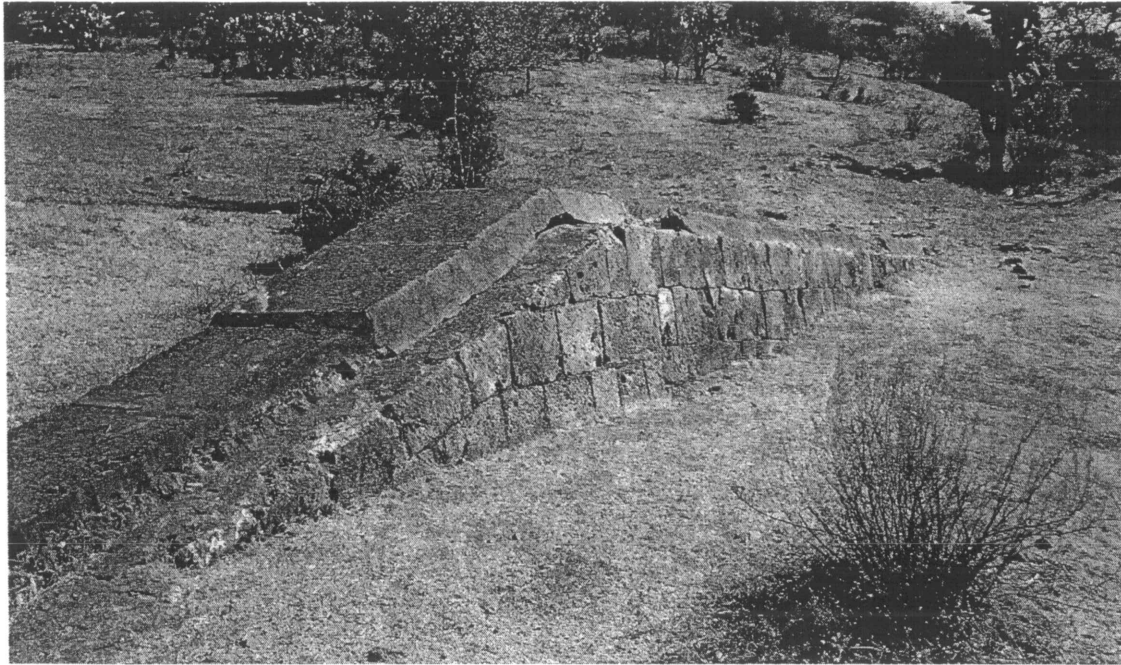
Ilustración 12: Acueducto de 1907 que actualmente sirve como conductor de agua desde el manantial de San Miguel del Monte hasta la planta potabilizadora de San Miguel.
