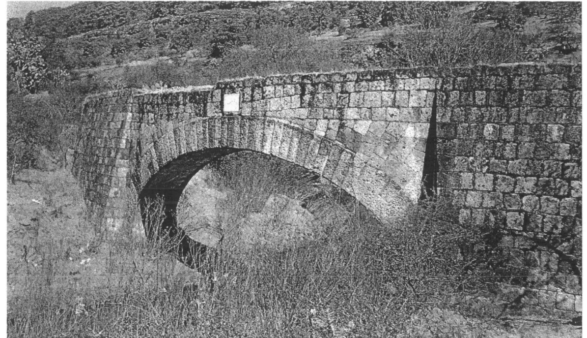
Ilustración 13: Acueducto de 1907 que actualmente sirve como conductor de agua desde el manantial de San Miguel del Monte hasta la planta potabilizadora de San Miguel.
