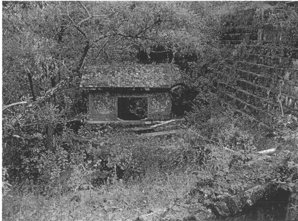
Ilustración 10: Restos de la planta de filtración de 1907.
