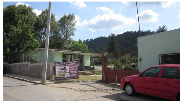
Escuela primaria rural en la localidad de San Miguel del Monte, en condiciones aceptables
