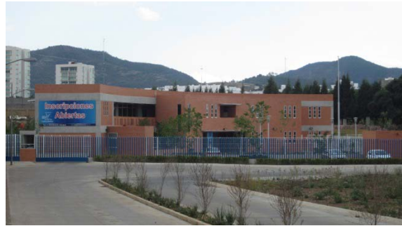
Jardín de niños particular sobre el camino a Jesús del Monte, con estacionamiento e instalaciones totalmente terminadas para su funcionamiento.
