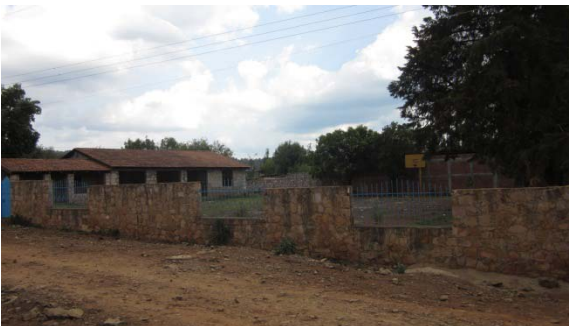
Casa ejidal en la localidad de San José de las Torres, amplia instalación en buen estado y con un módulo deportivo (cancha de básquet bol)
