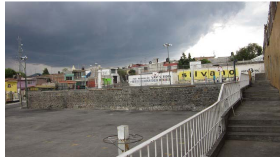
Explanada de usos múltiples también en la localidad de Santa María de Guido
