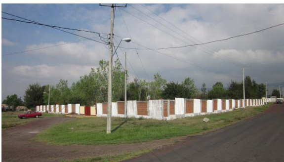
Escuela Secundaria Federal Rural en la localidad de La Estancia, que presenta aceptables condiciones de infraestructura
