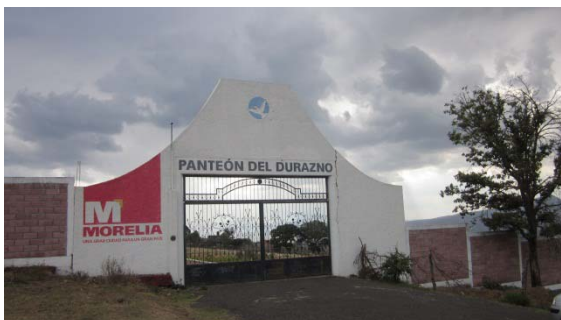
Cementerio en el Durazno, el cual presenta una gran superficie vacante para servicio futuro, se encuentra en buenas condiciones y totalmente bardeado
