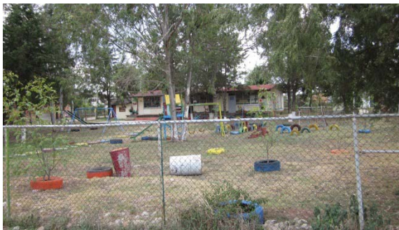
Jardín de niños en la localidad de San José de las Torres, presenta algunas instalaciones con necesidad de mantenimiento
